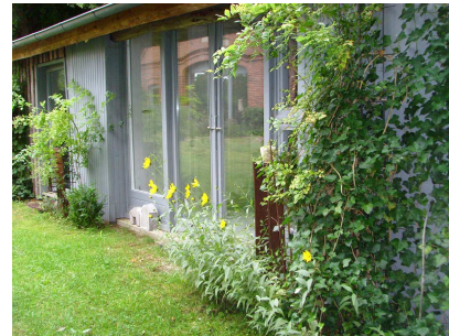
Blick auf die Werkstatt Räume
